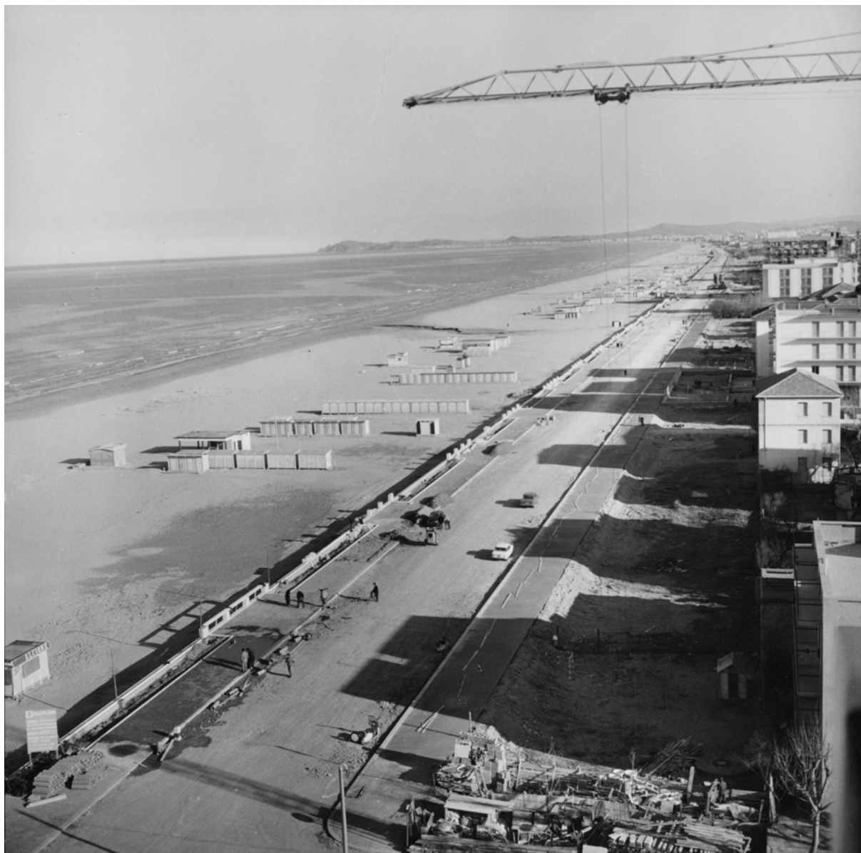
Rimini, 1965: lavori di costruzione del lungomare - fotografia di Davide Minghini (Biblioteca civica "Gambalunga", Rimini)
