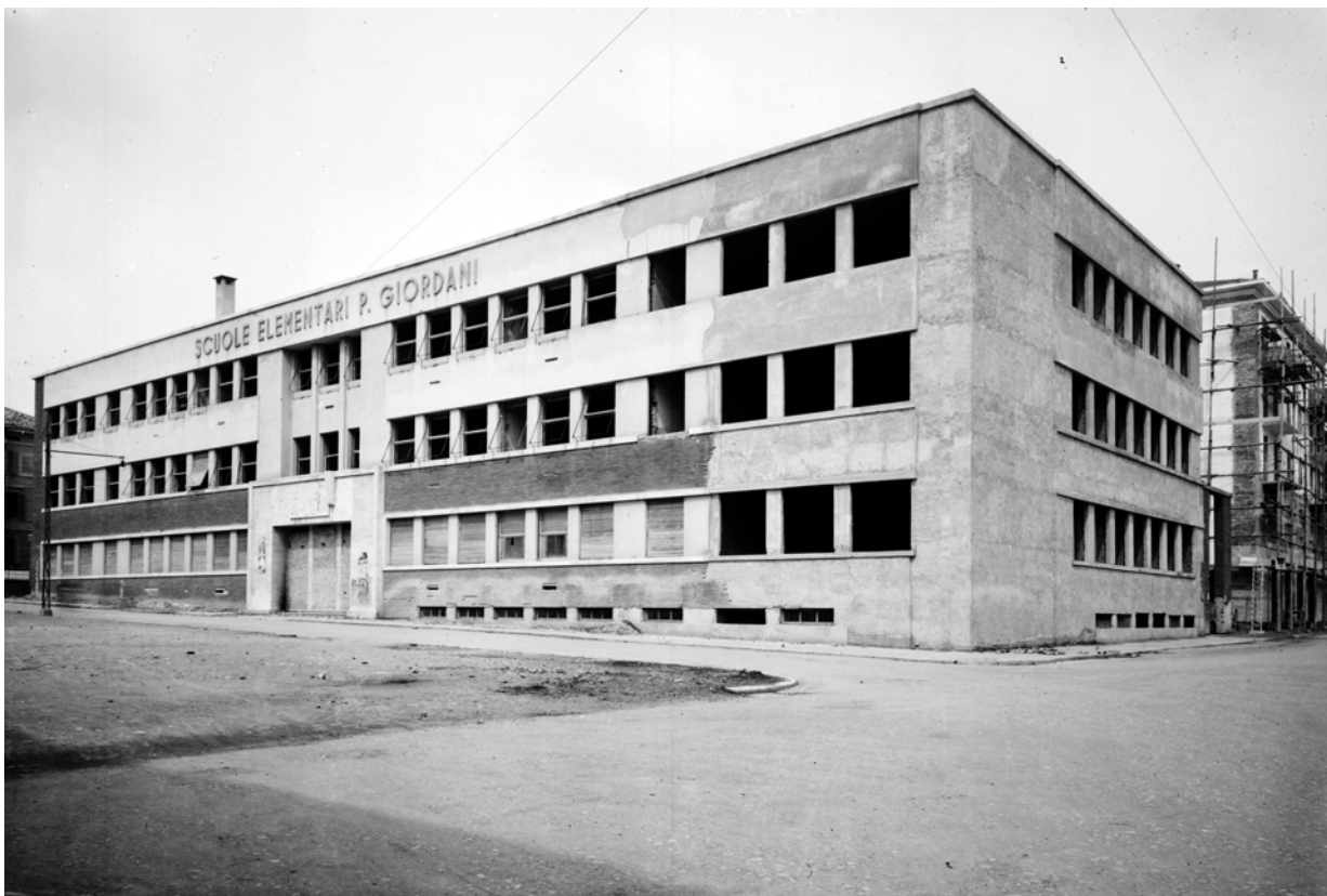
I restauri delle Scuole "Giordani" di Parma in un'immagine realizzata per il Genio civile intorno al 1960 – fotografia di Bruno Vaghi (Centro studi e archivio della comunicazione dell'Università di Parma)
