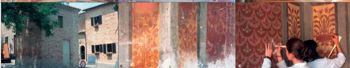
4. Le lesene ai lati dell'altare prima del restauro
