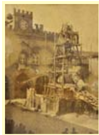
Momento del montaggio dell'obelisco a Garibaldi in una fotografia scattata il 29 aprile 1884
