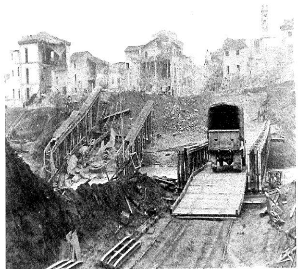
Il primo Ponte Bailey, poggiato sulla parte bassa dell'argine, servirà però solo per il traffico leggero. Fu costruito in una notte.
