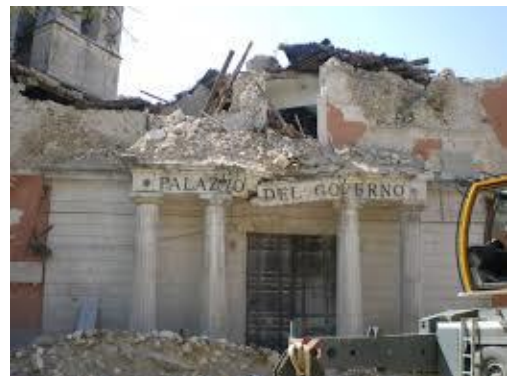
Terremoto in Abruzzo, aprile 2009
