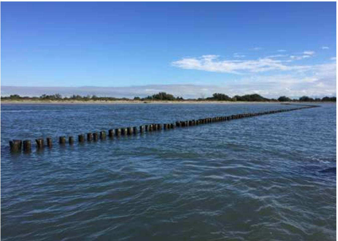
FIGURA 192 Scanno di Goro: 2 dei pennelli in pali di legno realizzati lungo lo scanno di Goro (in alto foto maggio 2017, in basso foto ottobre 2016).
