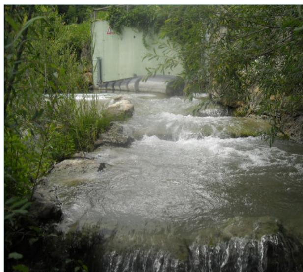
Figura 4 –Passaggio per pesci del tipo fish ramp (con boulder bars) realizzato sul fiume Savio, in località Montecastello. A dx scala di risalita in fase di ultimazione (2010). A sx scala di risalita dopo 8 anni dalla realizzazione.
