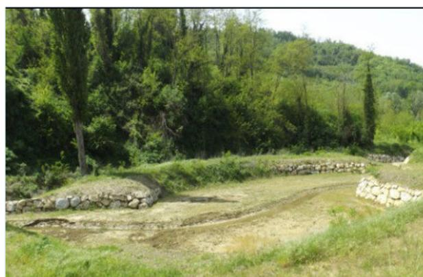
Figura 21 – Area di decantazione torrente Cesuola (particolari pennelli in massi)
