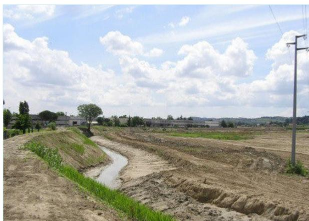
Figura 19 – Subito dopo i lavori sul torrente Cesuola a Case Castagnoli, ove demolito argine sinistro (foto da valle)
