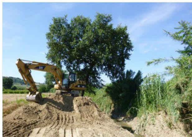
Figura 17 – Demolizioni degli argini sul torrente Pisciatello nel tratto collinare (Calisese)
