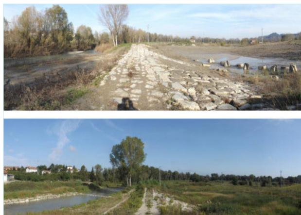
Figura 7 - Sfioratore in massi a fine lavori e dopo 6 mesi
