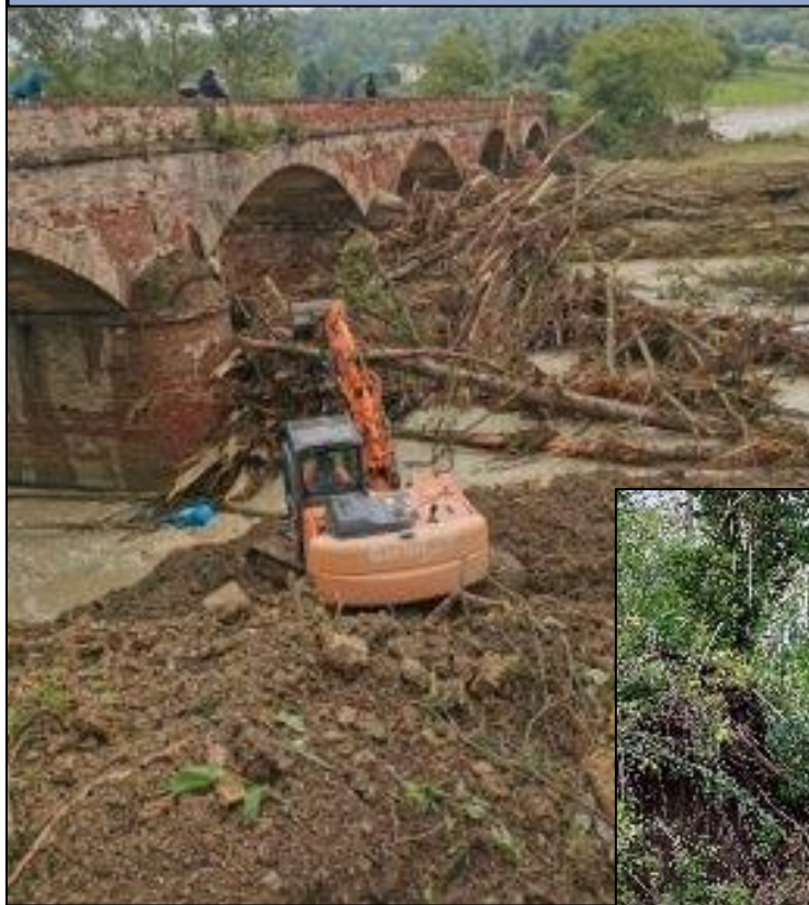
Pulizia vegetazione, rimozione accumuli e occlusioni
