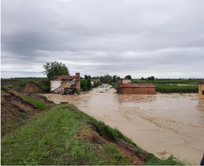
Crollo rilevato arginale per circa 80 metri Sormonti diffusi
