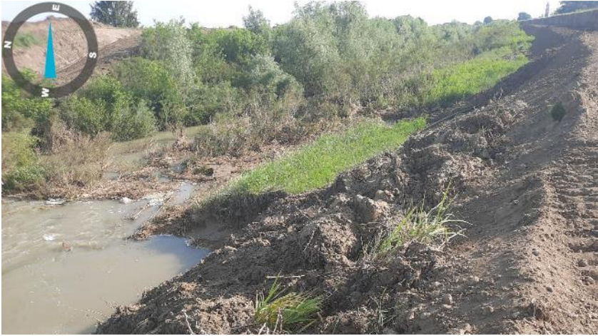
Crollo dei rilevati arginali in destra e sinistra a monte e a valle della rotta di Ca' di Lugo
