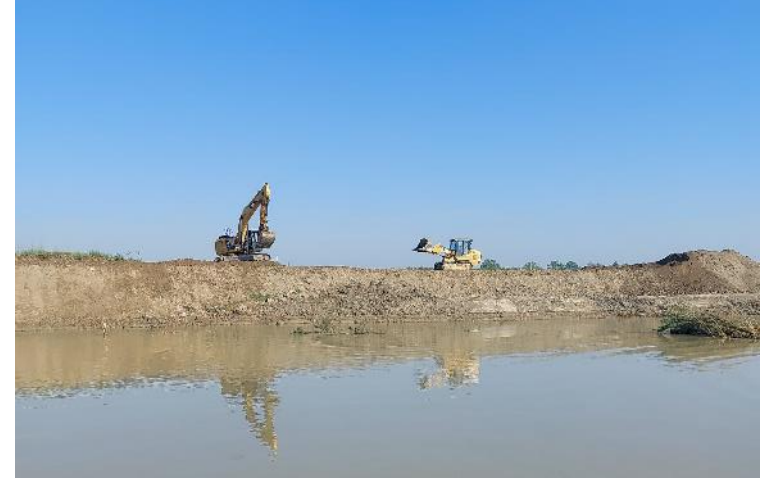
Ricostruzione dei rilevati arginali in sx
