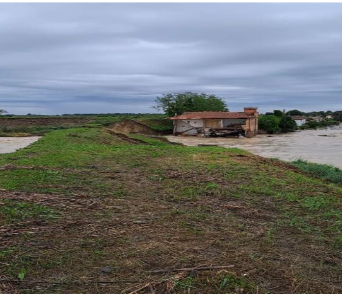
Crollo rilevato arginale per circa 80 metri Sormonti diffusi
