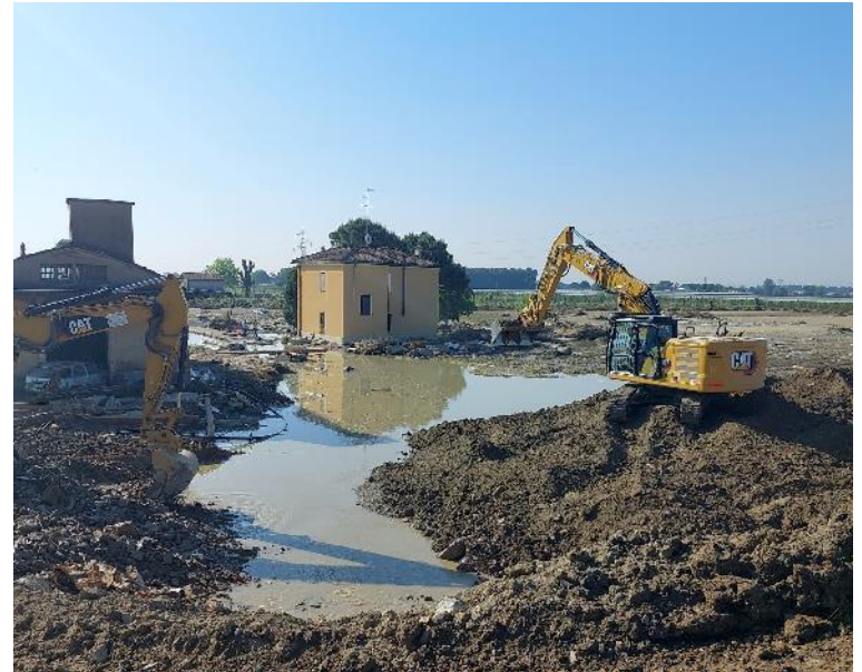
Ricostruzione dei rilevati arginali in dx
