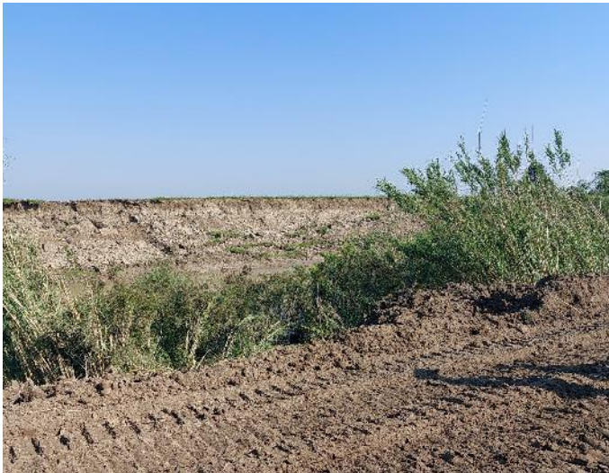
Crollo dei rilevati arginali in destra e sinistra a monte e a valle della rotta di Ca' di Lugo
