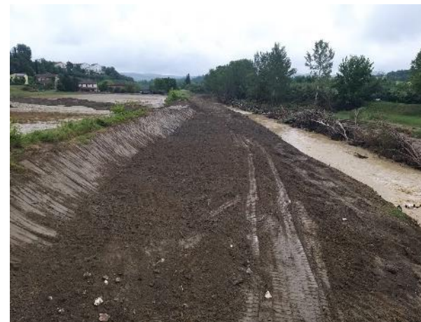
- Rimozione vegetazione caduta e ripristino argine
