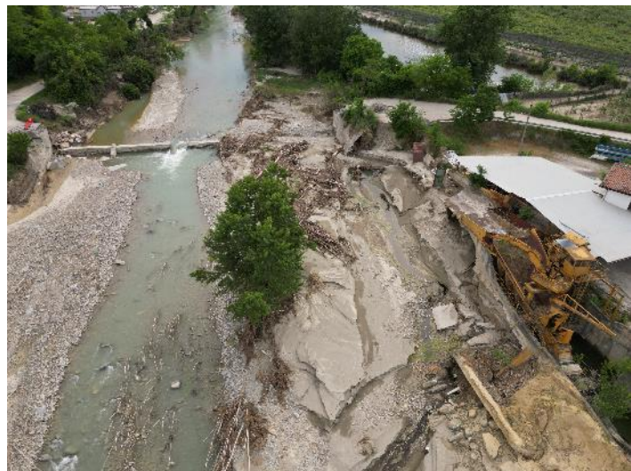
- Crollo di ponte con occlusione alveo
