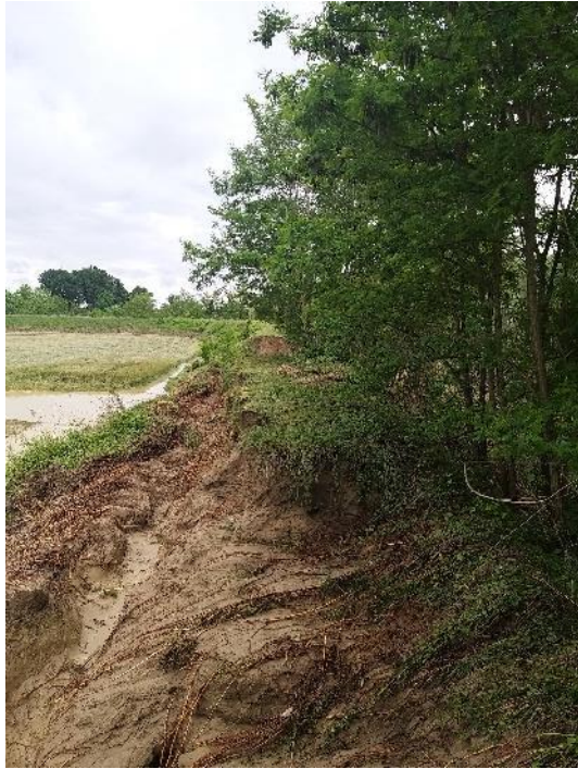
- Rottura arginale
