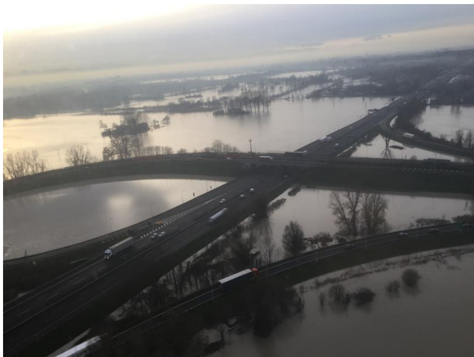
Figura 28: Svincolo della A22 Modena-Brennero
