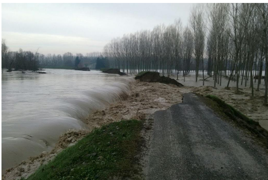
Figura 24: Rotture arginali
