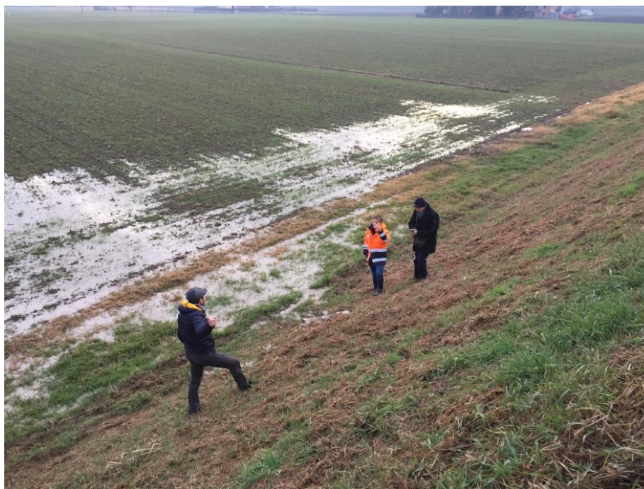
Figura 30: Filtrazioni arginali in corrispondenza dello stante ST32 in sinistra
