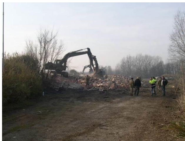
Figura 3 - Fabbricato completamente demolito
