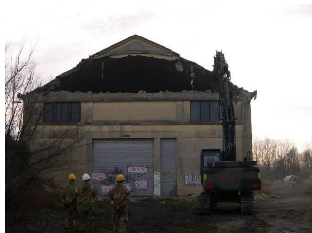
Figura 2 - Inizio della demolizione del fabbricato principale (gennaio 2015)
