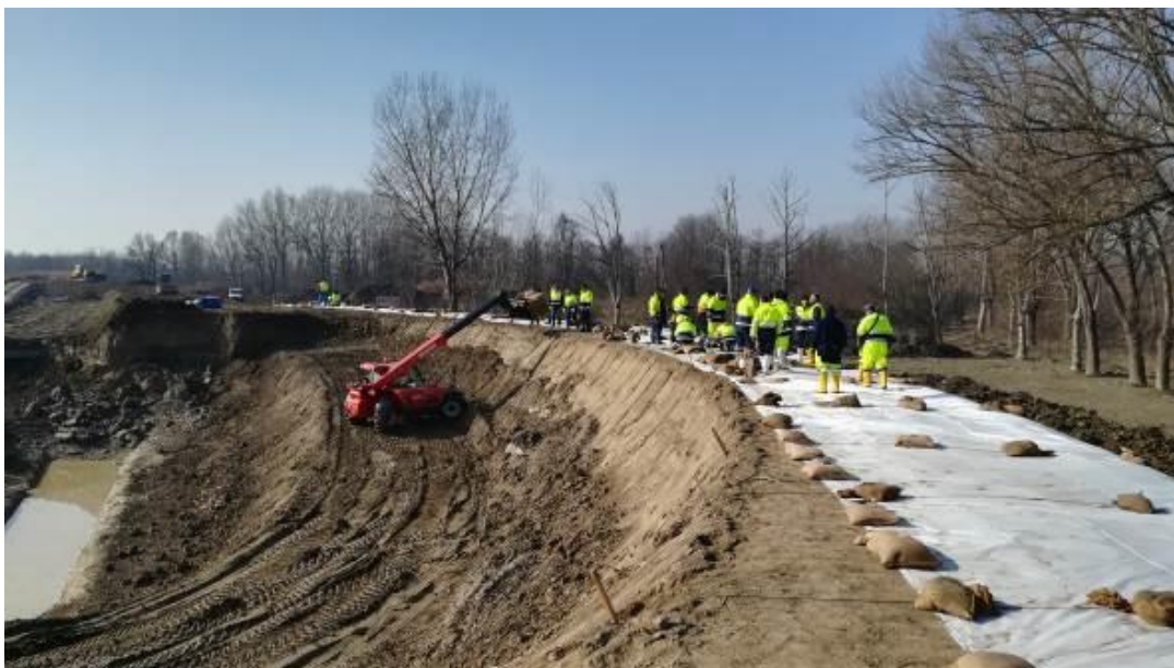
Figura 19 - Attività di telonatura eseguita dai Volontari di Protezione Civile (vista lato campagna)
