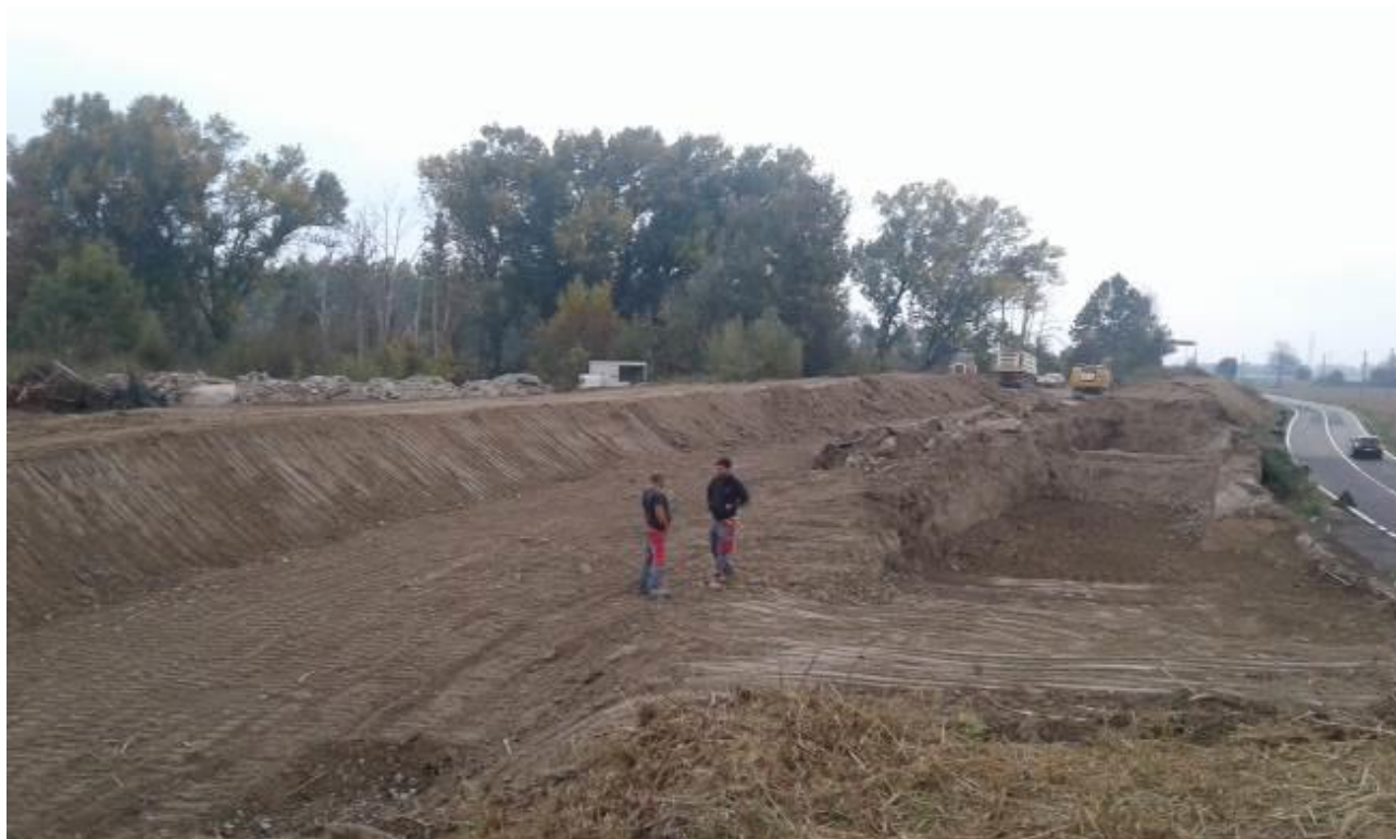
Figura 6 – Sbancamento già eseguito in parte e argine di protezione a tergo
