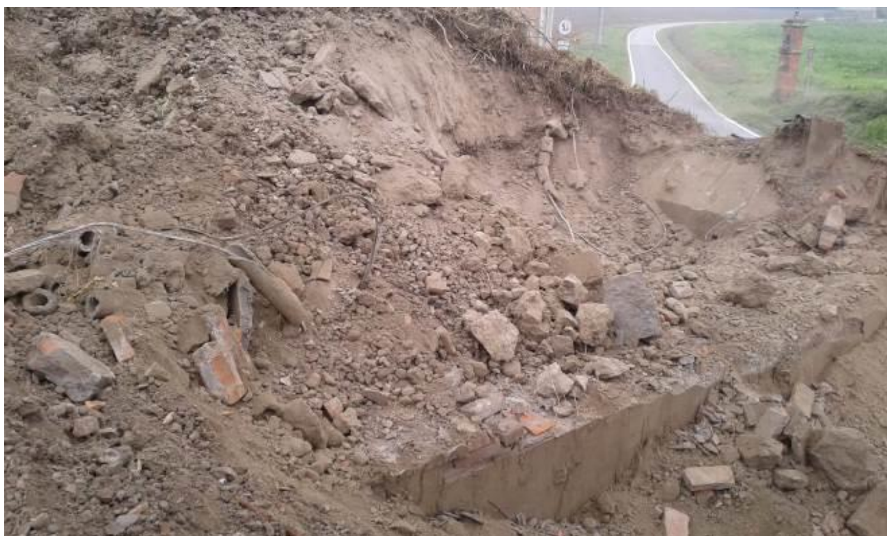
Figura 7 – Materiali rinvenuti all'interno della parte sommitale del corpo arginale nel corso dello sbancamento
