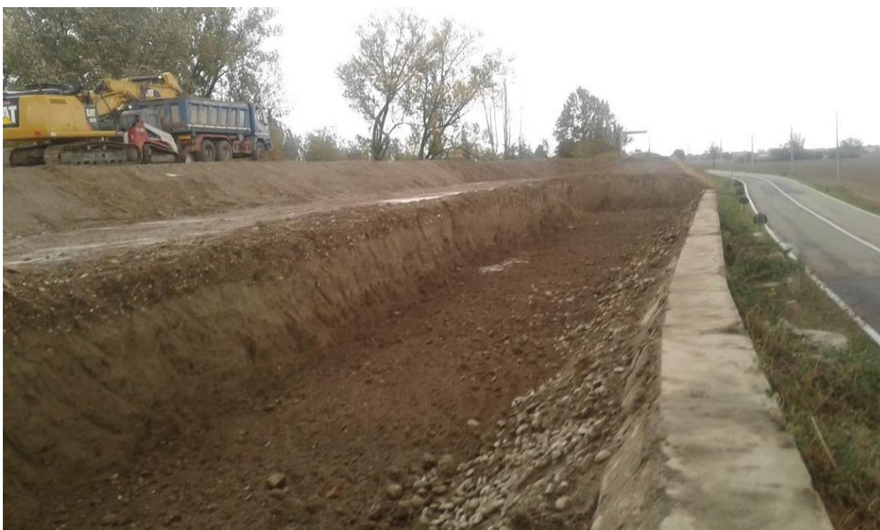
Figura 10 - Argine di protezione (vista verso valle)
