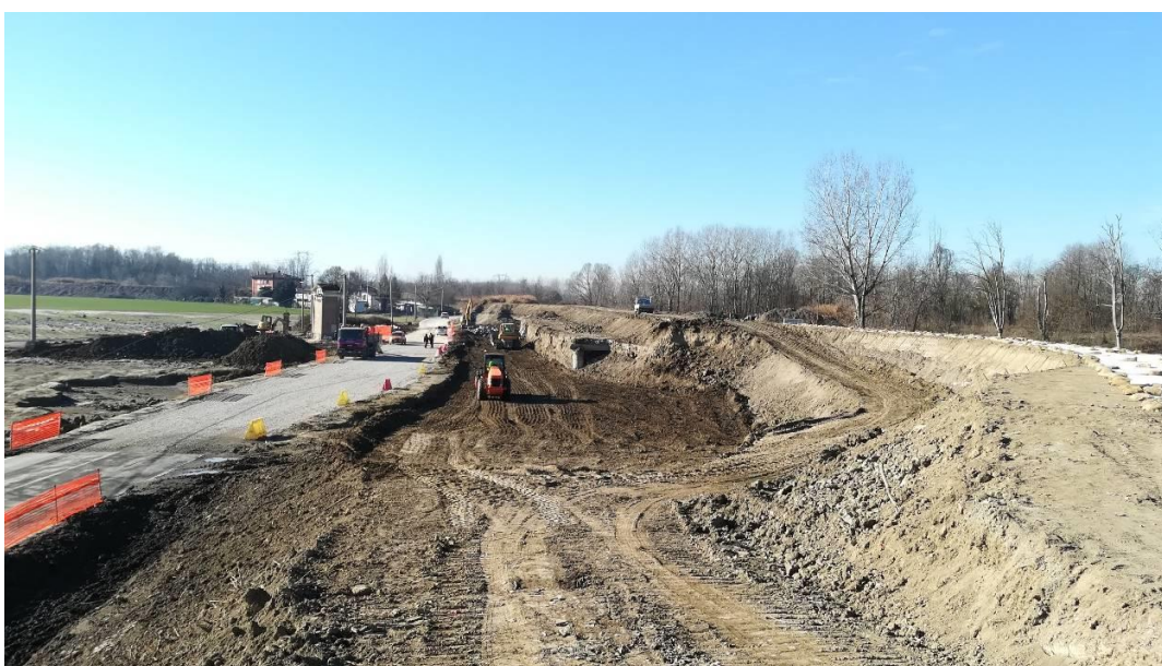
Figura 20 - Situazione al 13 febbraio – Strada completata ed inizio delle attività di costruzione dell'argine definitivo
