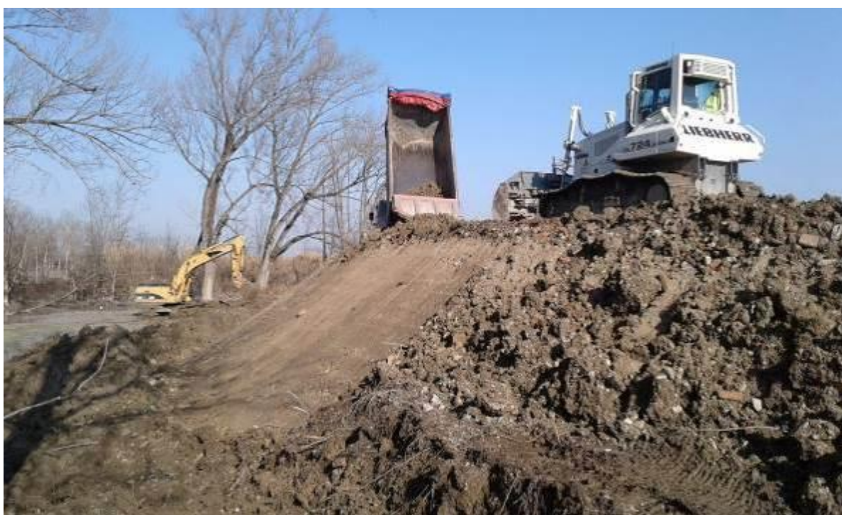
Figura 16 – Ringrosso della coronella contratto di materiale terroso, preliminare alla stesa di teloni
