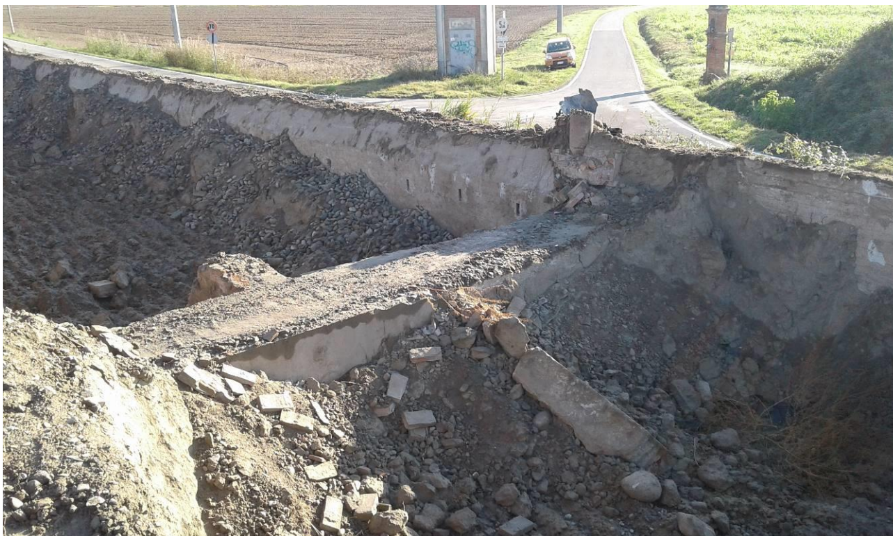
Figura 8 - Caratteristiche dei terreni alle spalle del muro di sostegno
