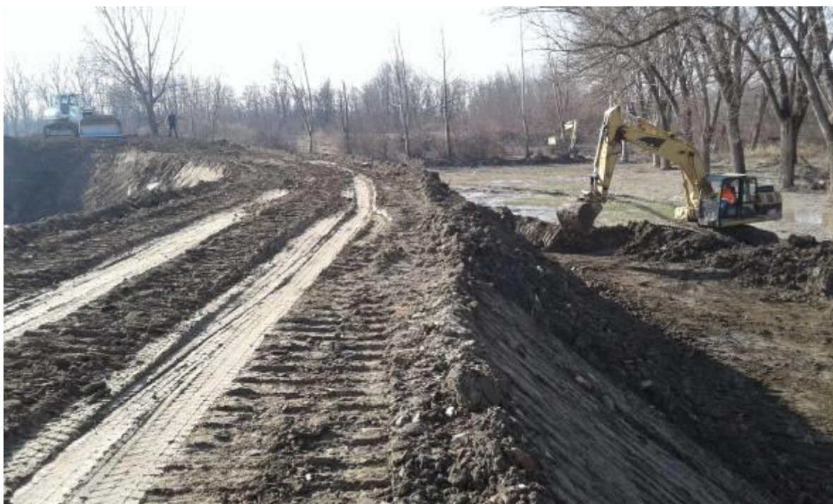
Figura 17 – Riquotatura dell'argine di protezione
