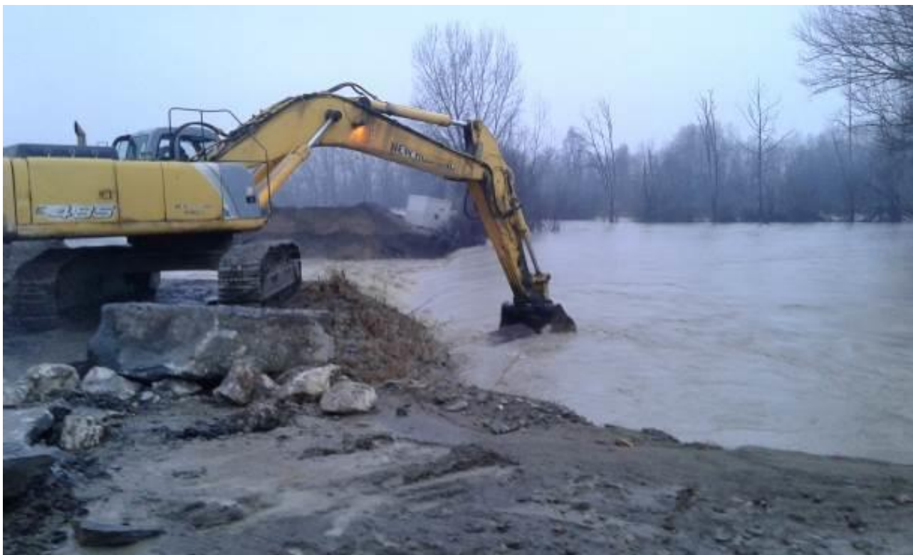
Figura 14 - Inizio delle operazioni di chiusura della rotta. Ore 17.00 del 2/2/2019
