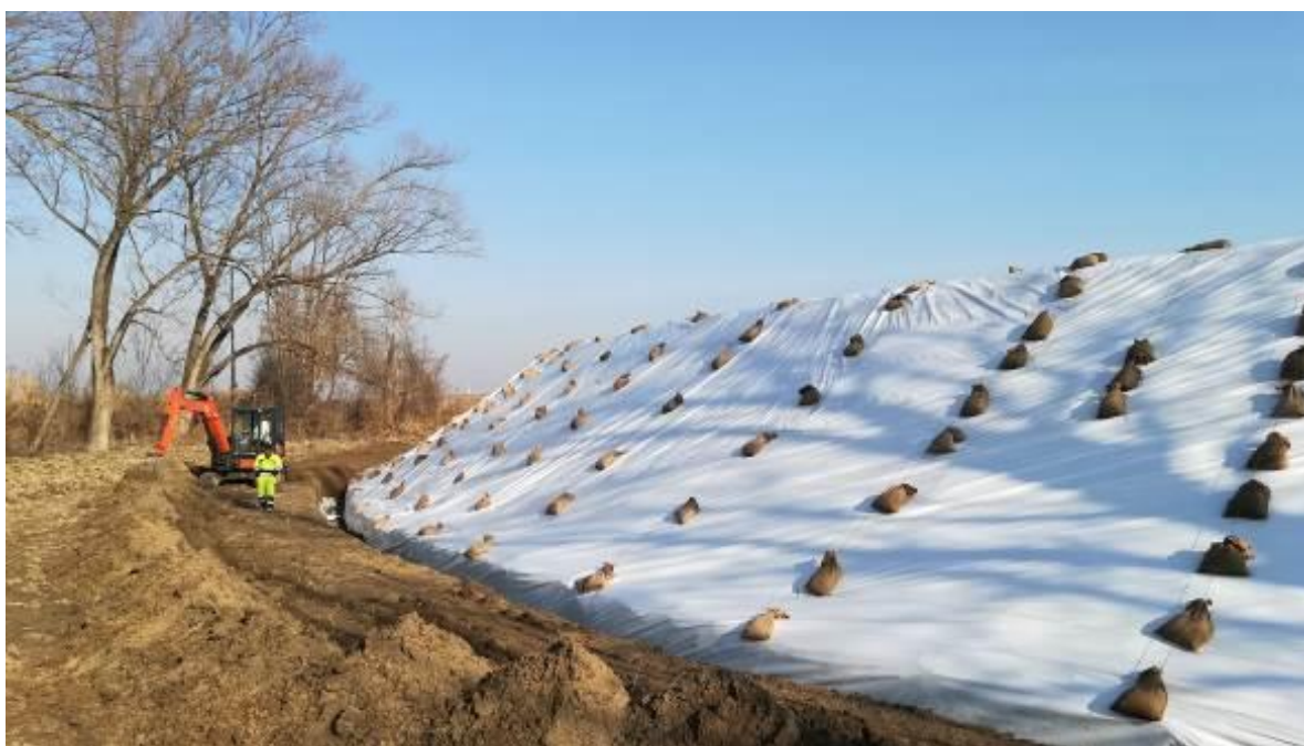
Figura 18 - Telonatura del paramento lato fiume dell'argine di difesa idraulica realizzato sulla coronella in massi posta a chiusura della breccia arginale
