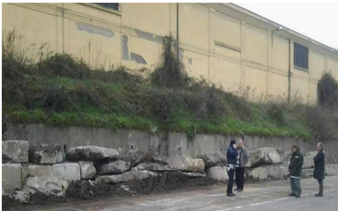
Figura 5 - Puntellamento del muro di sottoscarpa con massi ciclopici
