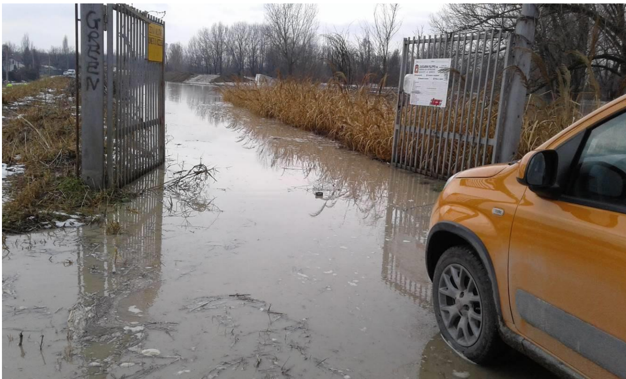
Figura 13 - Livello raggiunto dalla piena alle ore 11:38 nella zona non oggetto dei lavori
