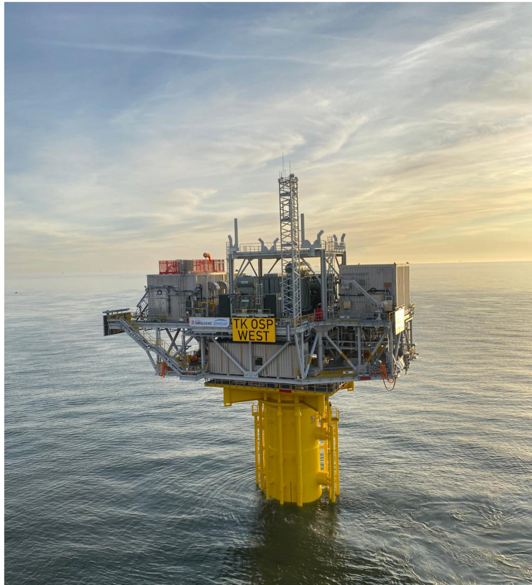
Le sottostazioni elettriche di trasformazione offshore si comportano da nodo di interconnessione per gli impianti di produzione di energia e, grazie all'impiego di apparecchiature elettromeccaniche, opera la trasformazione da 66kV a 220kV. Le due sottostazioni, sono ubicati in ciascun hub energetico:
