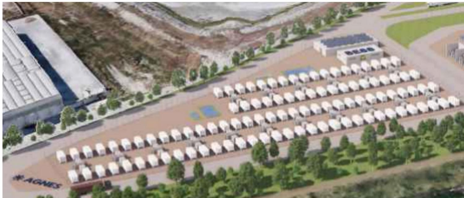
Il sistema di accumulo (impianto BESS) previsto in progetto ha potenza nominale complessiva di **50 MW** combaciante con la potenza di immissione/prelievo di 50 MW alla Rete Nazionale Terna.
