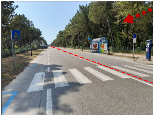
Met. Allacciamento FSRU di Ravenna (tratto a terra) DN 650 (26"), DP 100 bar - Vista contro senso gas su Lungomare C.Colombo
