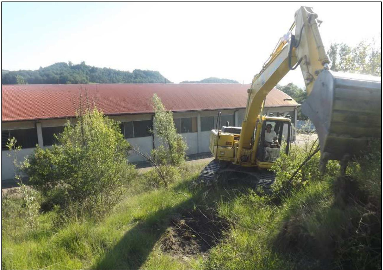
Foto n° 3 – esecuzione sondaggi con escavatore
